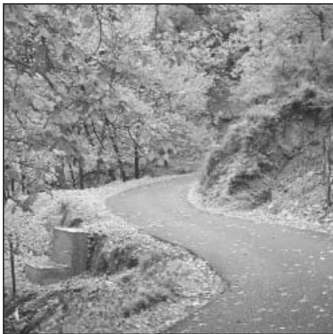
Uno scorcio della strada per la Contrada Pinazzo con la sorgiva realizzata in località "Ruttammare"
