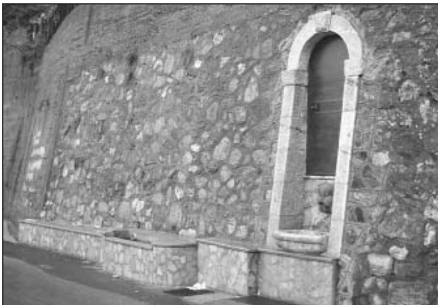
"L'Acqua Vena" dopo i lavori di sistemazione
