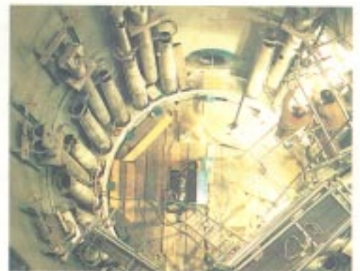
Operai specializzati all'interno del vessel
