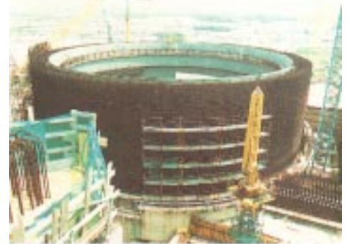
Il cantiere della centrale nucleare di Alto Lazio
