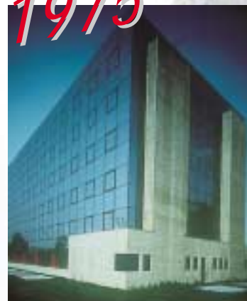
Sede Etas Compas di Segrate (MI), progetto Arch. Claudio Dini • Grande Complesso per uffici con impiego armonizzato di elementi "tradizionali" costituiti dai blocchi in cls con l'elemento "moderno" costituito dalle superfici curtain wall.
