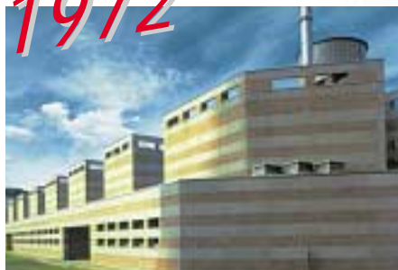
Centrale AEM di Cassano d'Adda (MI), progetto Prof. Arch. Mario Bellini. • Esempio di grande insediamento industriale con impiego di blocchi in CLS di notevole respiro progettuale.
