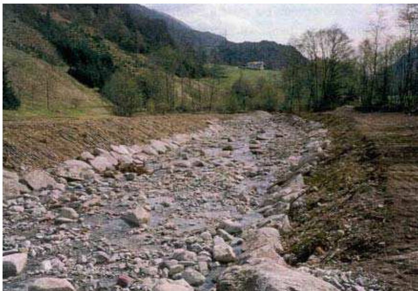
Fig. 10 - Un immagine delle "coperture diffuse" realizzate nei pressi di Lardaro, a lavori appena ultimati.
