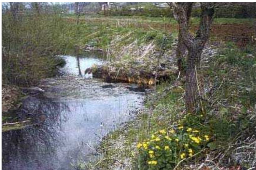
Fig. 14 - Deflettore-ricovero a lavoro finito
