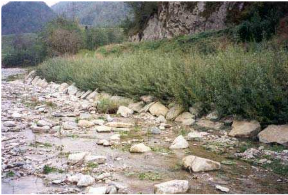
Fig. 11 - Un immagine delle "coperture diffuse" realizzate nei pressi di Lardaro. Si noti lo sviluppo degli astoni di salice, a distanza di circa un anno e mezzo dalla loro posa
