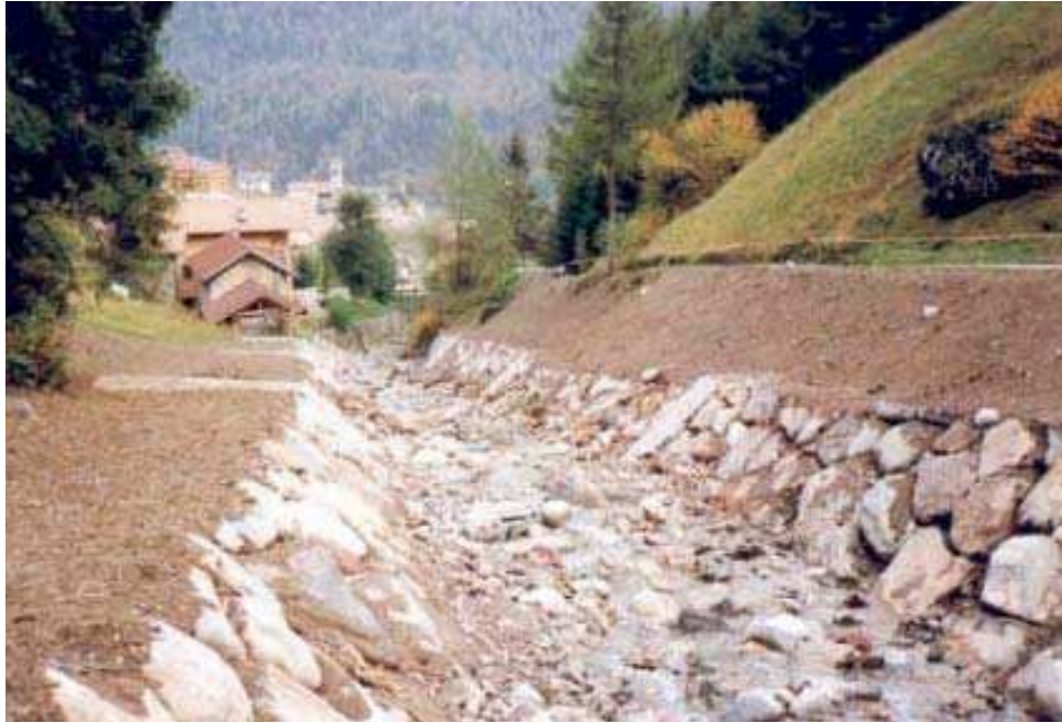
Fig. 9 - Il tratto del torrente Adanà che precede l'abitato di Roncone ad interventi di sistemazione idraulico-forestale ultimati.
