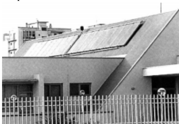
Figura 2.8 - Pannelli su una scuola elementare di Lecce (foto: Costruzioni Solari srl).
