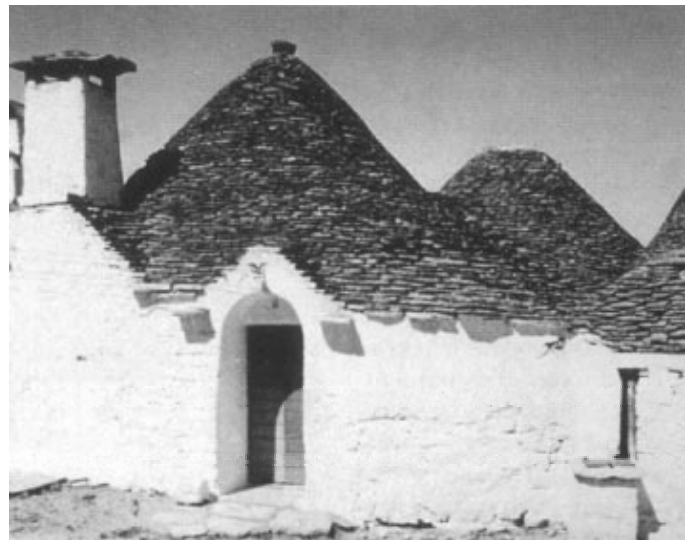
Figura 4.3 - Un trullo della Puglia settentrionale. Il principio è lo stesso del dammuso, il surriscaldamento indotto dalla pietra scura di copertura viene smaltito consentendo la fuoruscita dell'aria calda da un'apertura in cima al cono. [2]
