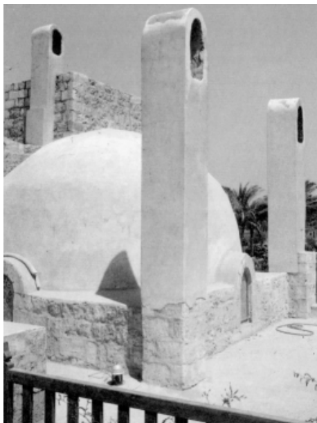
Figura 4.5 - Camini a vento ( malqaf ) su una casa egiziana. Di frequente contengono tappeti o carbonella umidi per rinfrescare ulteriormente il vento che vi entra. [2]
