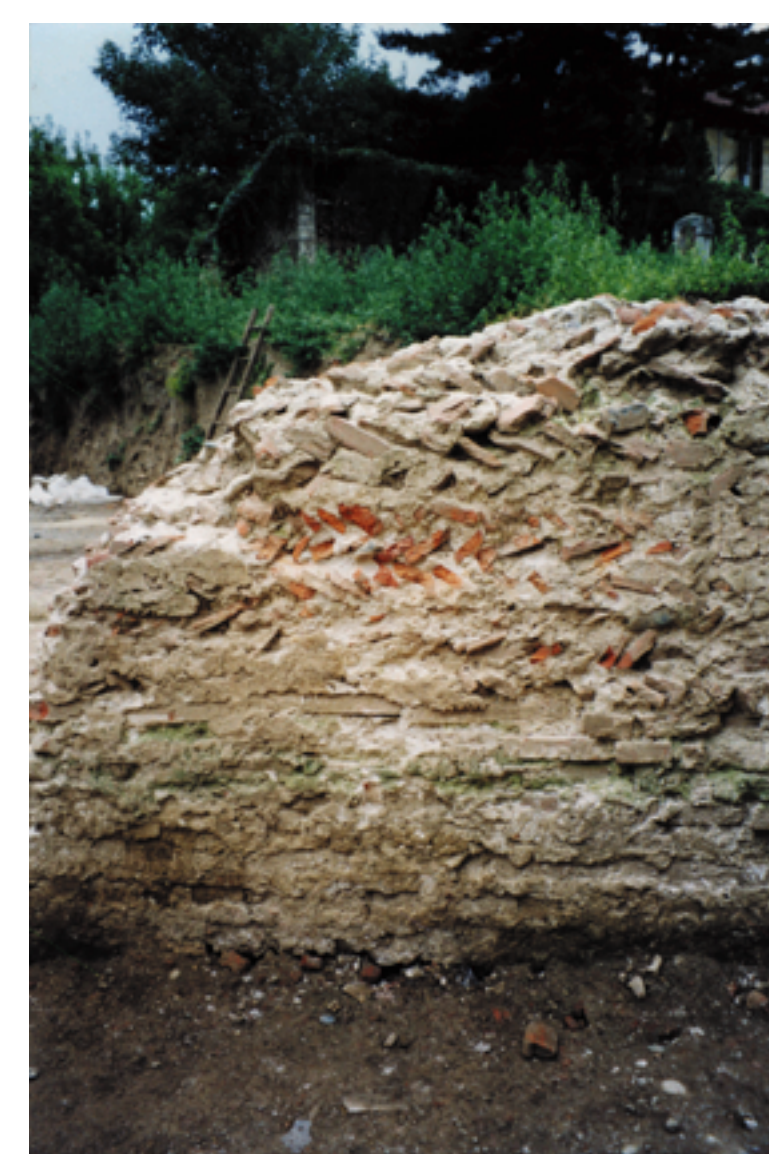
Foto n. 3 Particolare da nord (vedi pianta al n. 4) del muro nord della "torre". Si noti la caratteristica tecnica di costruzione a "spina pesce".
